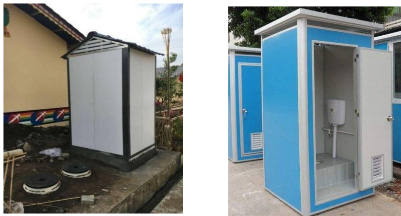
图25 集成式装配水冲厕示意图
