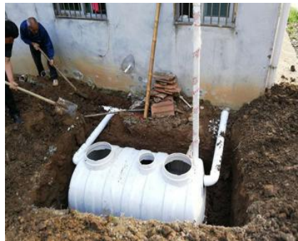
图9 化粪池埋设及管道安装
