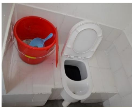
图16 改造后的粪尿分集式生态厕所
