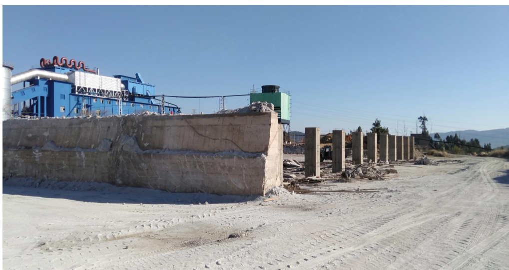
水淬渣临时库现状图
