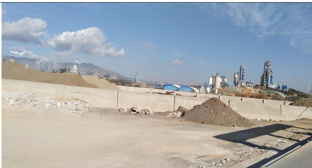
原料库整改前现状
